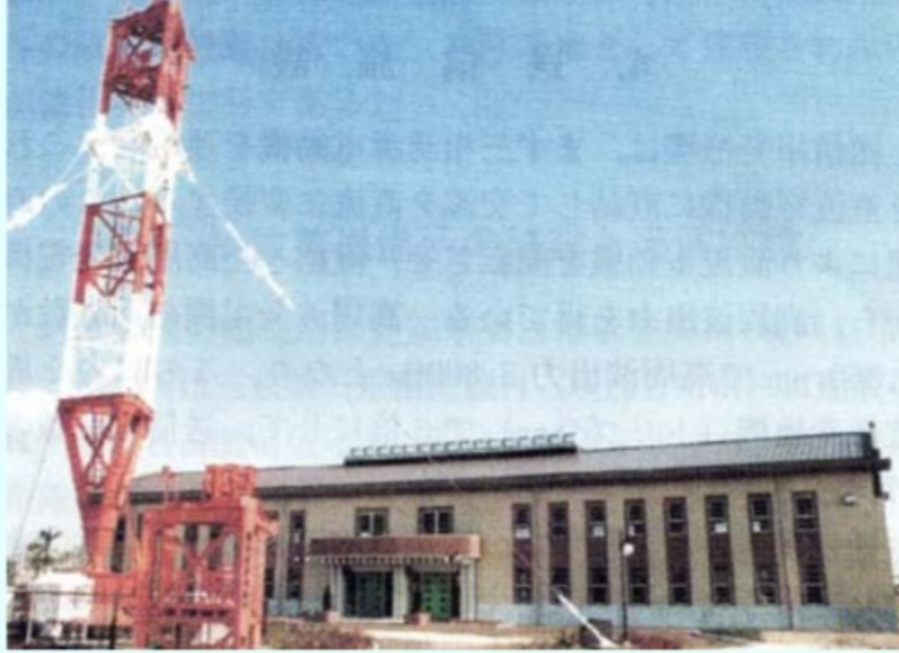
写真3 依佐美送信所記念館と鉄塔基部
